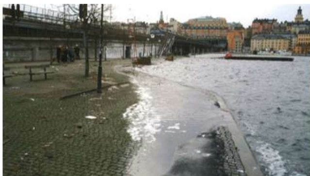
Översvämning från Mälaren vid Gamla stans tunnelbanestation år 2000. Foto: Länsstyrelsen Stockholm
