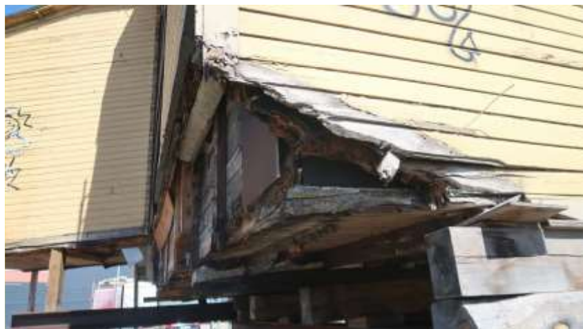
Figur 2. Skadad träkonstruktion
