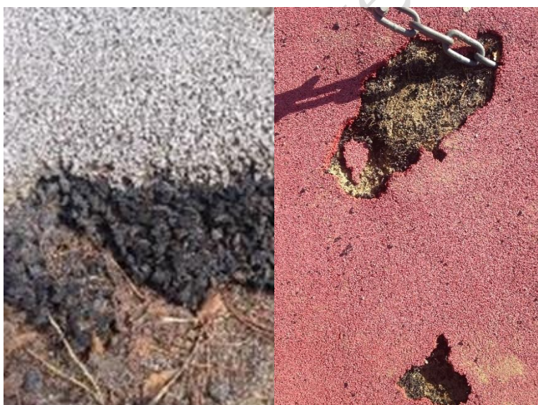
Figur 7 - Platsgjutet gummi med fallskydd på lekplats. Grått och rött topplager av EPDM, svart baslager av SBR, återvunna bildäck
