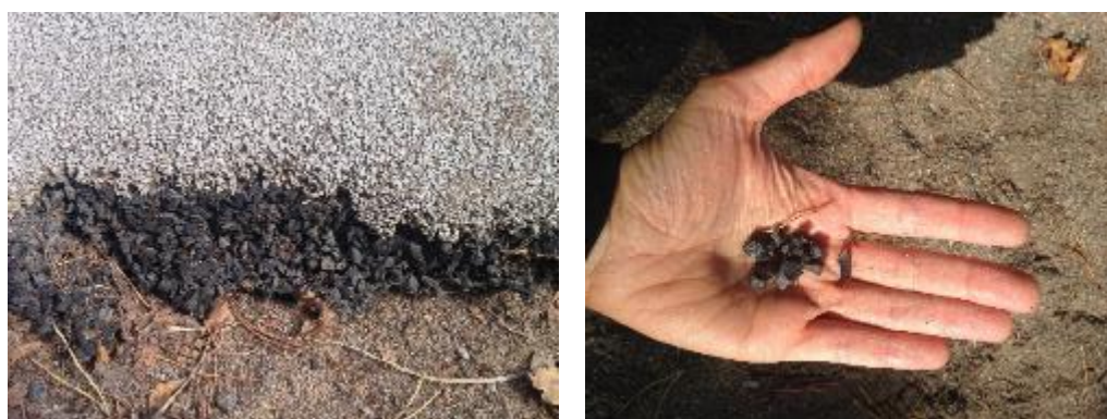
Till vänster en trasig yta och till höger lösa SBR-bitar på lekplatsen Lurparken. Bildkälla: Sofie Lindgren
