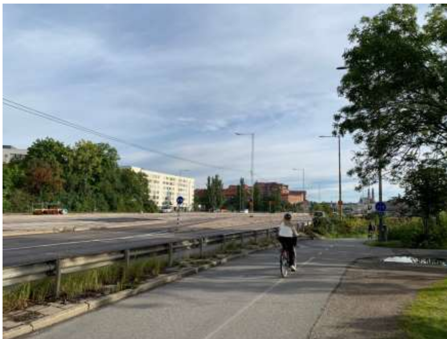
Figur 4. Plats där ny gång- och cykelpassage och ny cykelbana ansluter till befintlig gång- och cykelväg på Södertäljevägens östra sida. Liljeholmens centrum syns i foden på motsatt sida Södertäljevägen.
