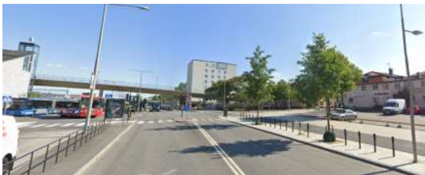
Figur 5. Foto som visar Spånga stationsväg Söderut vid Värsta Allé efter ombyggnad. Kontoret har anlagt en separerad gång- och cykelbana till höger, nya cykelställ och träd har planterats i skyddszon mot körbanan.
