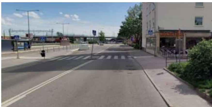
Figur 6. Foto som visar Spånga stationsväg söderut vid busstation före ombyggnad. På sträckan fanns tidigare en smal gångbana och ingen cykelbana, övergångsställe var inte hastighetssäkrat.
