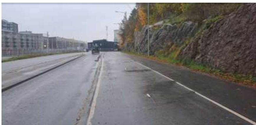
Figur 11. Foto som visar Bromstensvägen söderut mellan Sörgårdsvägen och Spånstigen efter ombyggnad. På sträckan har kontoret anlagt en breddad samt separerad gång- och cykelbana.
