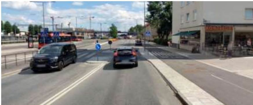
Figur 7. Foto som visar Spånga stationsväg söderut vid busstation efter ombyggnad. Kontoret har anlagt en breddad gångbana och ny cykelbana. Övergångsstället har hastighetssäkrats genom avsmalning och ramper.
