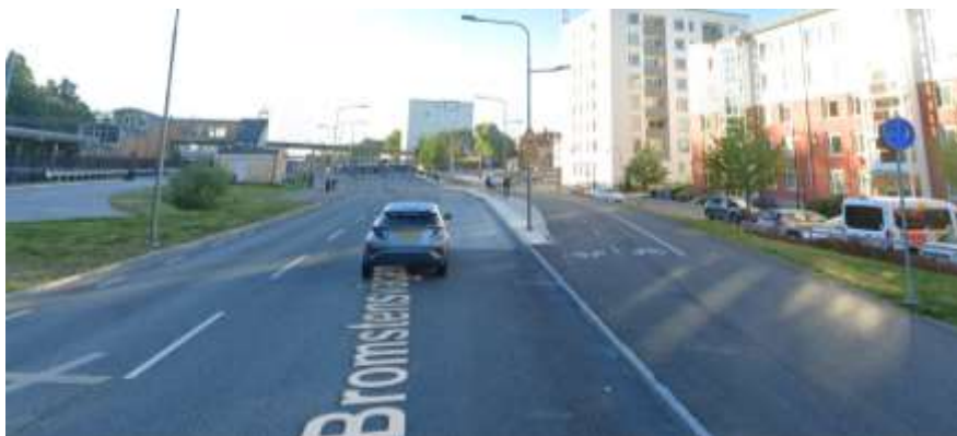
Figur 3. Foto som visar Bromstensvägen söderut mot Spånga station efter ombyggnad. Den gemensamma gång- och cykelbanan har breddats upp till separerad gång- och cykelbana.
