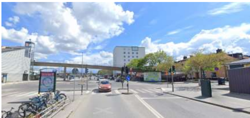
Figur 4. Foto som visar Spånga stationsväg söderut vid Värsta Allé före ombyggnad. Bilden visar en smal gemensam gång- och cykelbana till höger.
