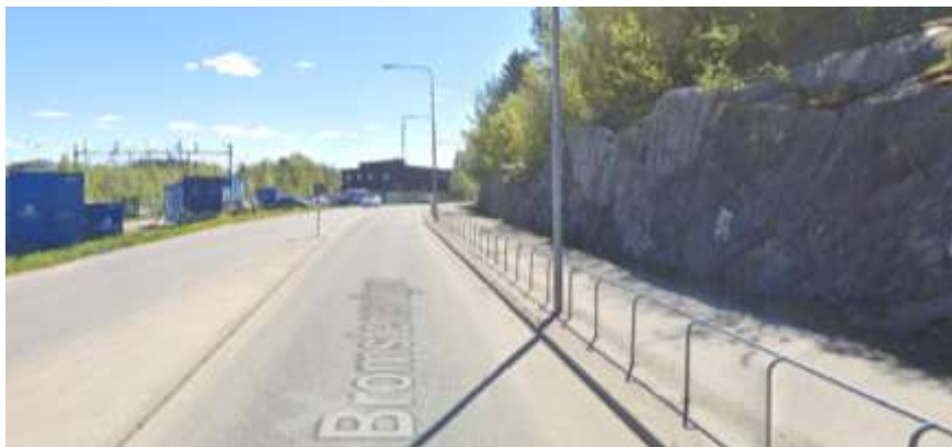
Figur 10. Foto som visar Bromstensvägen söderut mellan Sörgårdsvägen och Spånstigen före ombyggnad. På sträckan fanns tidigare en smal gemensam gång- och cykelbana.
