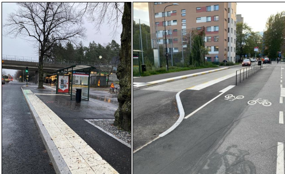
Figur 28. Tillgänglighetsanpassning av hållplats Skogskyrkogården och hållplats Bryggvägen
