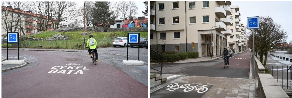
Figur 17, nya och breddade gång och cykelbanor på Drottningholmsvägen förbi Alvik
