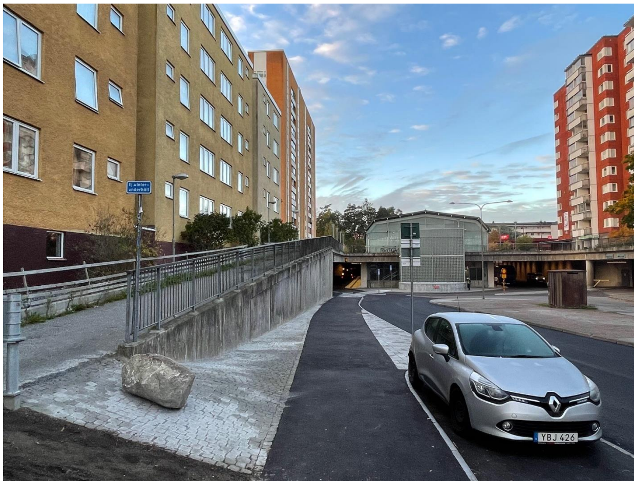
Figur 6. Längs Sveaborgsgatan i Akalla har en ny gångbana anlagts med koppling till Akalla tunnelbana och bussterminal.
