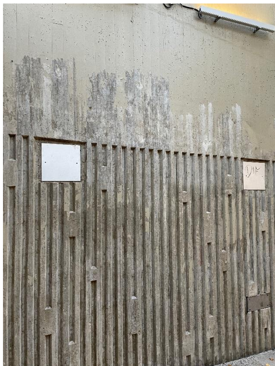
Dåligt skick av Betong och fel användning av väggar led till slitage
