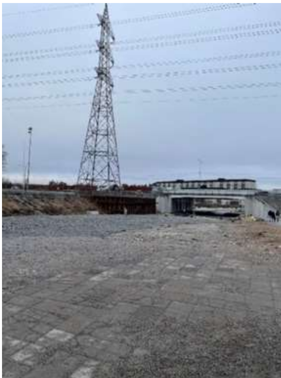
Yta vid Arne Beurlings torg före åtgärder.
