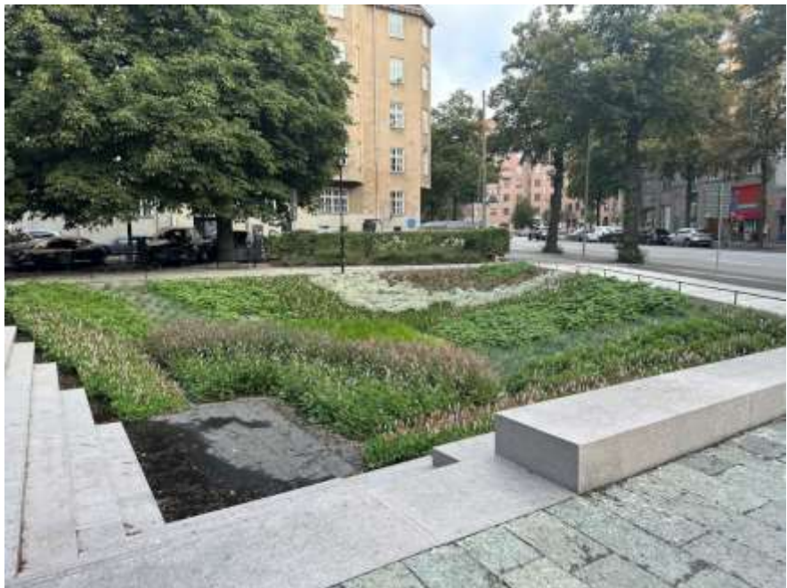
Figur 4. Bilden visar den nedsänkta torrdammen vid Jarlaplan efter byggnationen. I dammen har flertalet växter planterats.
