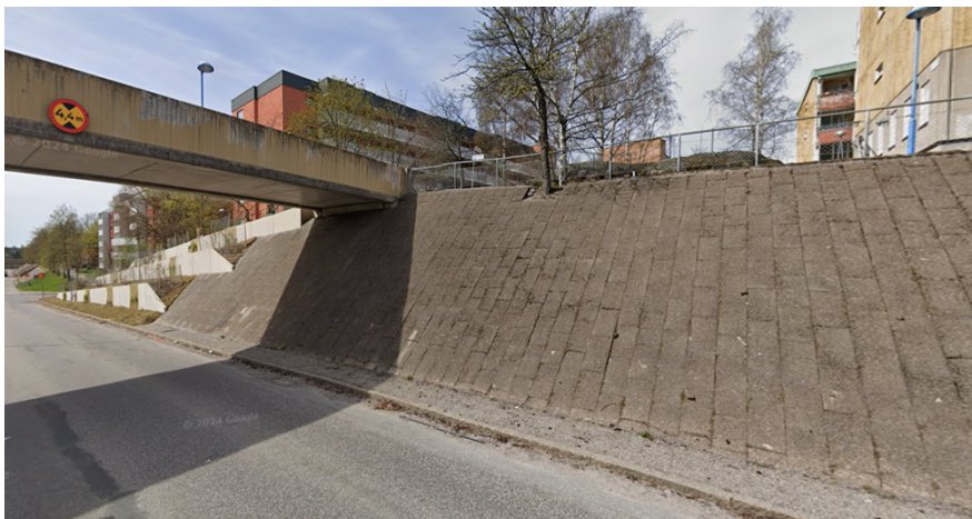
Figur 3. De betongklädda glaciserna längs Hagstråket sedda från gatunivå.
