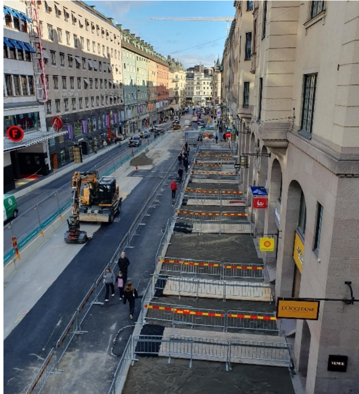
Figur 11. Bild visar produktionen under utförande av skedet närmast fasaden. Samtliga entréer har haft full tillgänglighet under hela entreprenaden.
