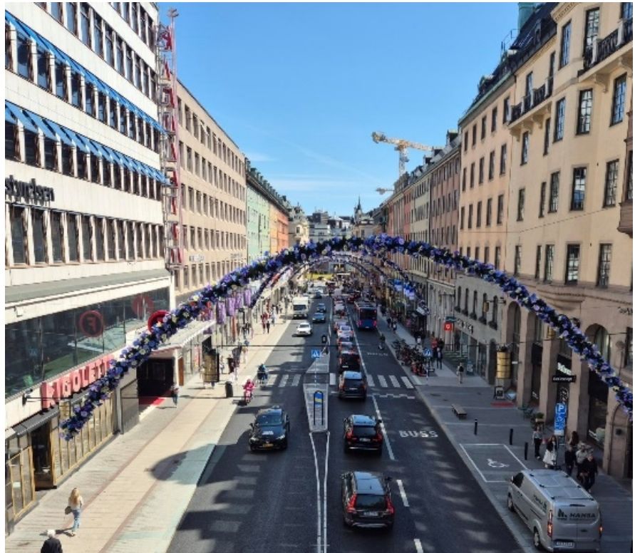
Figur 3. Kungsgatan efter ombyggnation, foto taget från Regeringsgatans bro österut mot Stureplan.
