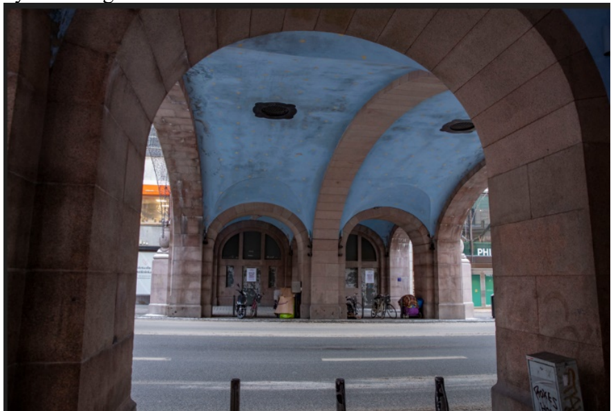
Figur 4. Foto som visar brovalven under Regeringsgatans bro innan nytt konstverk målats.
