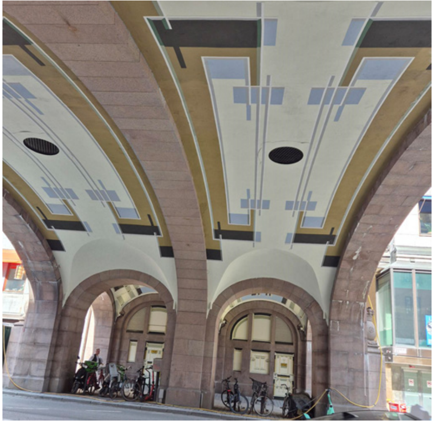
Figur 5. Foto som visar brovalven under Regeringsgatans bro efter nytt konstverk målats.
