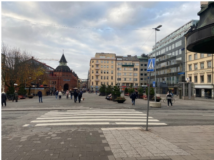
Bild 28. Fotografiet visar torget sett från Storgatan efter trafikförvaltnings återställning av ytorna efter deras tätskiktsbyte 2023. Kontoret hade ställt ut urnor och soffor under perioden inför upprustningens start.
