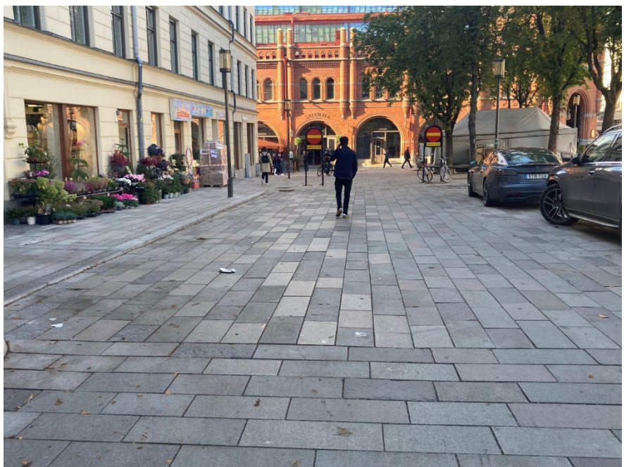
Bild 7. Fotografiet visar hur lokalgatan på södra delen av torget ser ut efter upprustningen. Nya granithällar både på kör- och gångytorna med inslag av återanvända granithällar från torget. På bilden ses även de nya lägre belysningsstolparna med topparmaturen. Bilden tagen från Sibyllegatan med saluhallen i bakgrunden.
