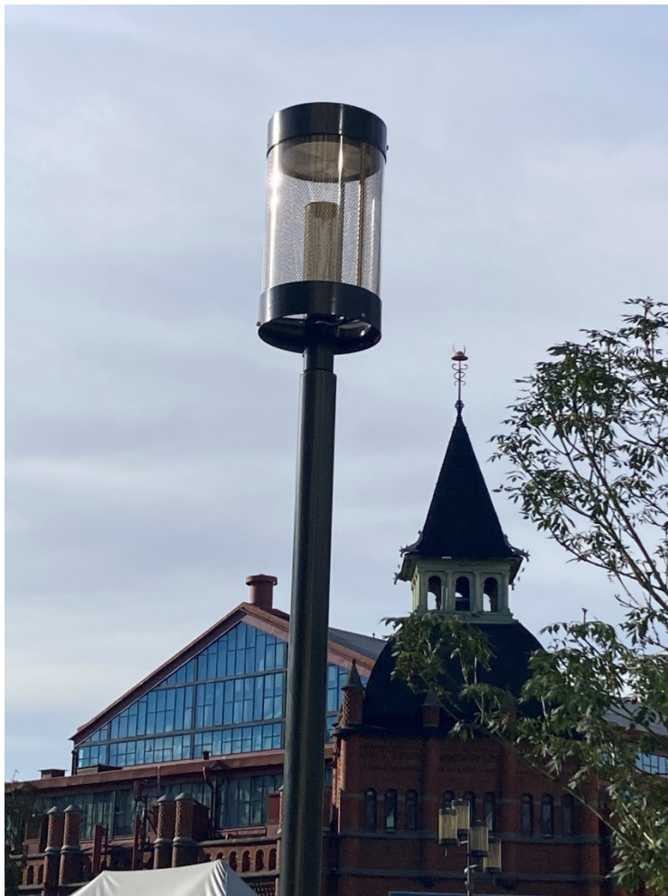
Bild 20. Fotografiet visar en detaljbild på den lägre belysningsstolpen med topp monterad armatur.
