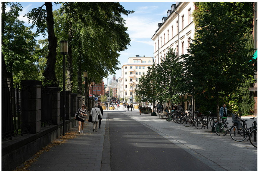
Bild 4. Fotografiet visar Storgatan sett från Jungfrugatan ner mot torget efter renoveringen. På bilden syns de nya betongplattorna på gångytorna och den nyasfalterade cykelbanan. Till vänster syns de nyplanterade träden, cykelställ och soffor.
