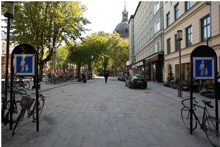
Bild 9. Fotografiet visar hur lokalgatan på södra delen av torget ser ut efter upprustningen. Nya granithällar både på kör- och gångytorna med inslag av återanvända granithällar från torget. På bilden syns även de nya lägre belysningsstolparna med topparmaturen samt vändplatsens utformning. Bilden tagen från Nybrogatan.
