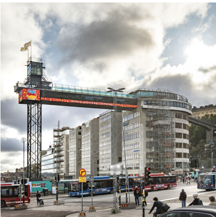
Katarinahissen är en viktig förbindelse mellan Katarinaberget och kajnivån. Foto: Stockholm stad
