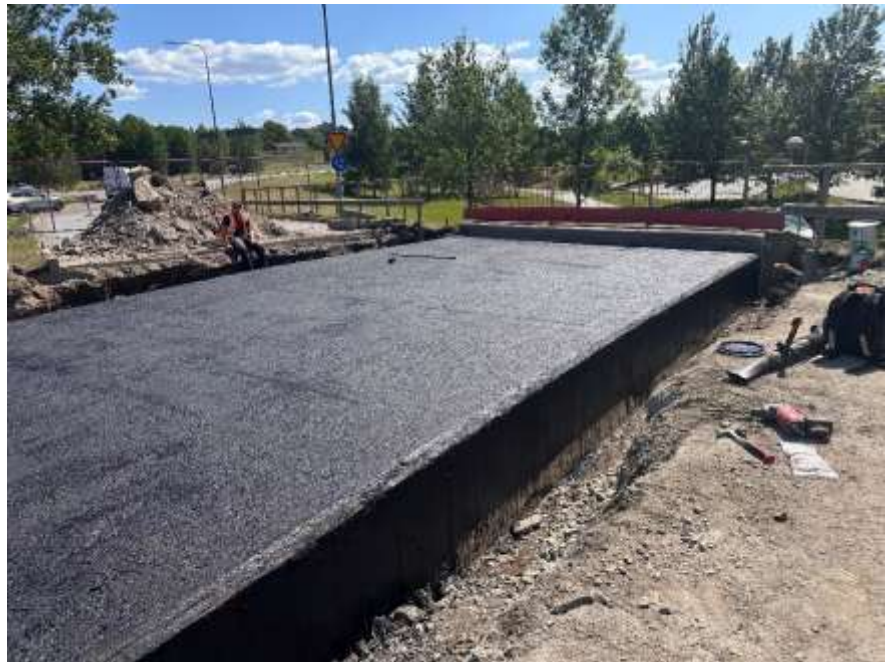
Figur 3: Entreprenad tätskiktsbyte i Kista
