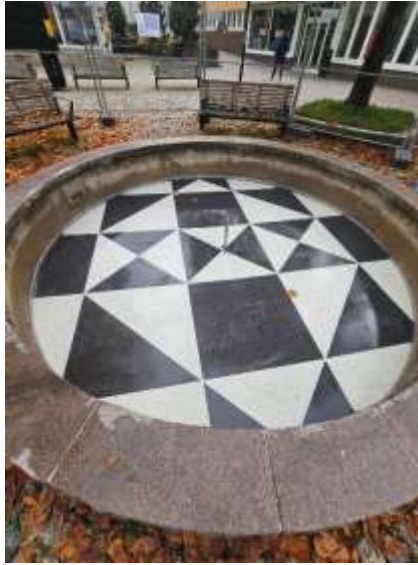
Figur 3 Fotografi som visar fontänbotten efter renovering
