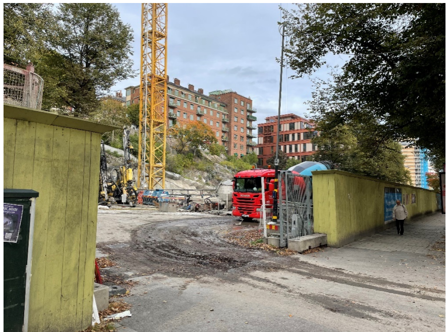
Figur 3. Fotografi som visar arbetsområde för utbyggnaden av nya tunnelbanestationen i Stigbergsparken.
