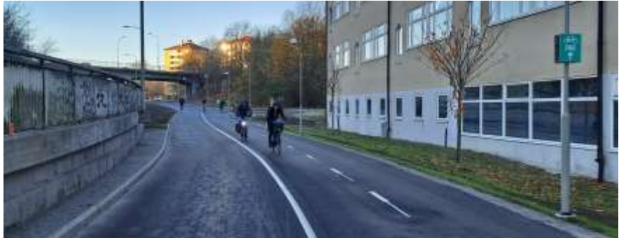
Figur 8. Foto som visar gång- och cykelbanan i riktning mot Gullmarsvägen i höjd med Värmdö Gymnasium efter ombyggnad, sträckan har nu en separerad gång- och cykelbana med breddmått enligt gångplan och cykelplan.
