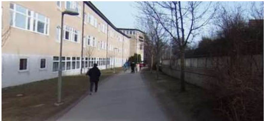
Figur 9. Foto som visar gång- och cykelbanan i riktning mot Skanstullsbron vid Värmdö gymnasium före ombyggnad, den gemensam gång- och cykelbana var smal.
