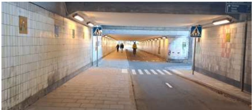
Figur 4. Foto som visar gång- och cykelbanan i tunneln i riktning mot Gullmarsplan efter ombyggnad. Gångbanan är breddad och en tydlig väntyta för gående har anlagts vid övergångsstället på gångbanan från Skanstullsbron.
