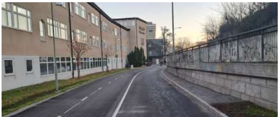
Figur 10. Foto som visar gång- och cykelbanan i riktning mot Skanstullsbron vid Värmdö gymnasium efter ombyggnad, den nyanlagda gång- och cykelbana är separerad och har breddmått enligt gång- och cykelplan.
