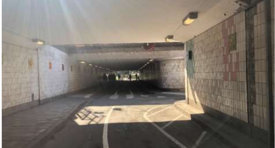
Figur 3. Foto som visar gång- och cykelbanan i tunneln i riktning mot Gullmarsplan före ombyggnad. Gångbanan är smal och väntyta för gående saknas.
