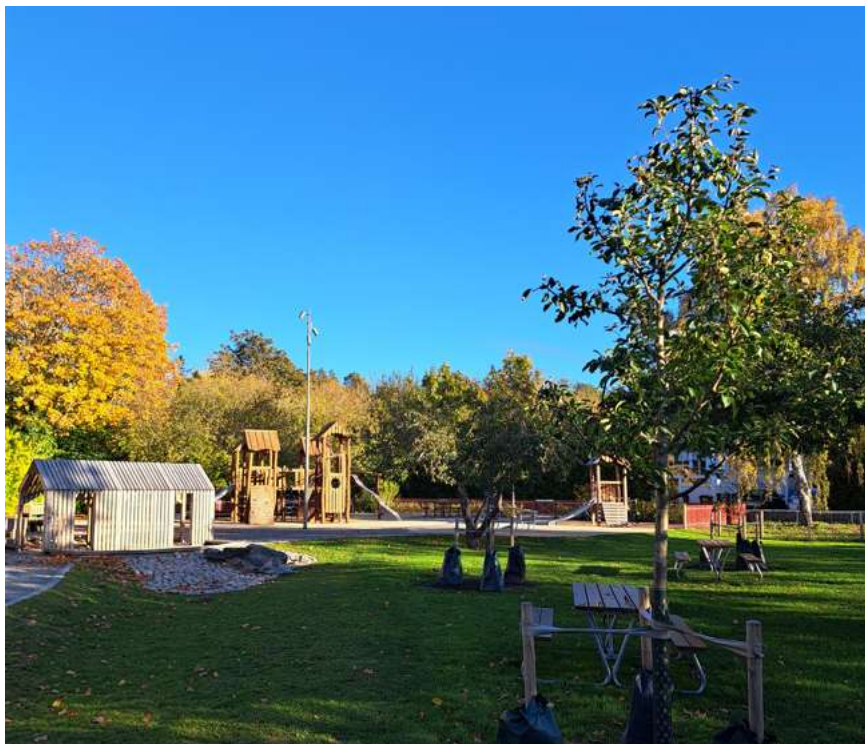
Bild 13. Fotografi i som visar samma del av lekplatsen efter ombyggnationen. På platsen finns nyplanterade träd och framför lekhuset har en sänka anlagts för uppsamling av dagvatten. Den nya klätterställningen i bakgrunden har införskaffats och uppförts på stadsdelsförvaltningens bekostnad.
