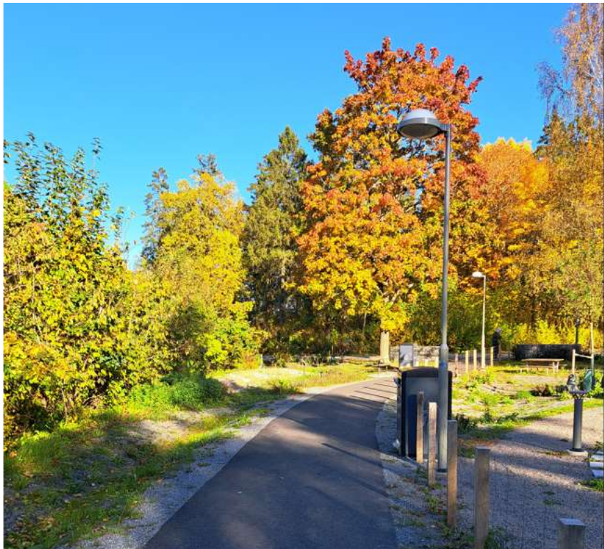
Bild 15. Fotografi som visar gångvägen mot Gribbyvägen efter ombyggnationen. Till höger syns en sänka för uppsamling av dagvatten, och närmast i bild på vänster sida gångvägen finns en nyanlagd ängsyta och lite längre bort en så kallad sandblotta för insekter.
