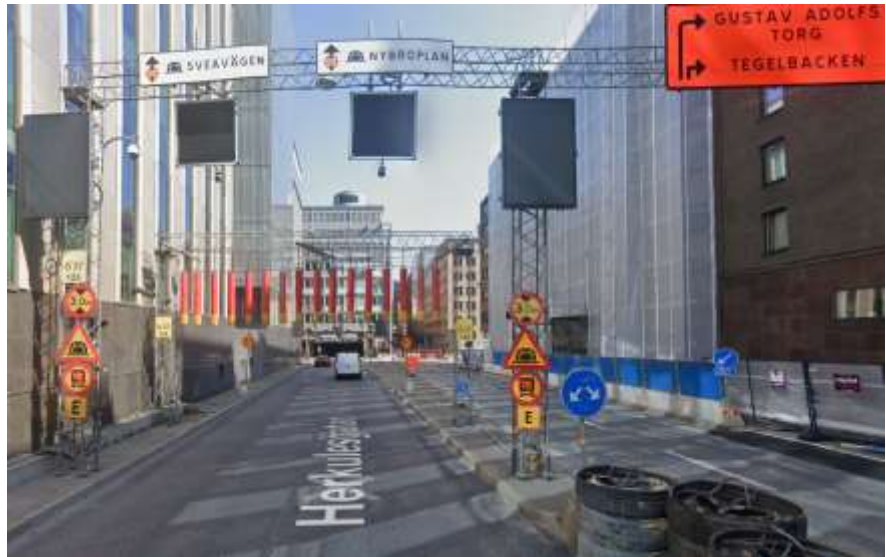
Figur 2 Varningsskyltar och rasselportal.
