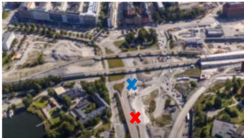
Figur 2: Flygfoto norrifrån över Norrtull, kvarter Sapienza markerat med rött kryss och kvarter Trinity markerat med blått kryss.
