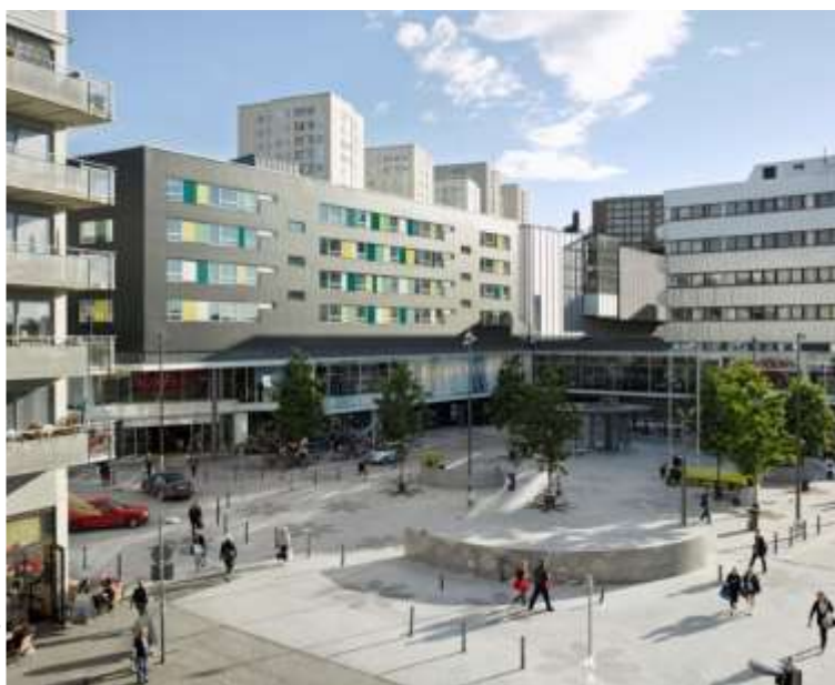
Bild 3: Delar av etapp 2 (kv. Stubinen).
