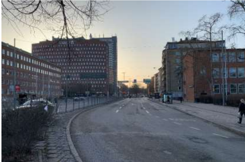
Figur 2 Rålambsvägen, vy västerut mot Gjørwellsgatan
