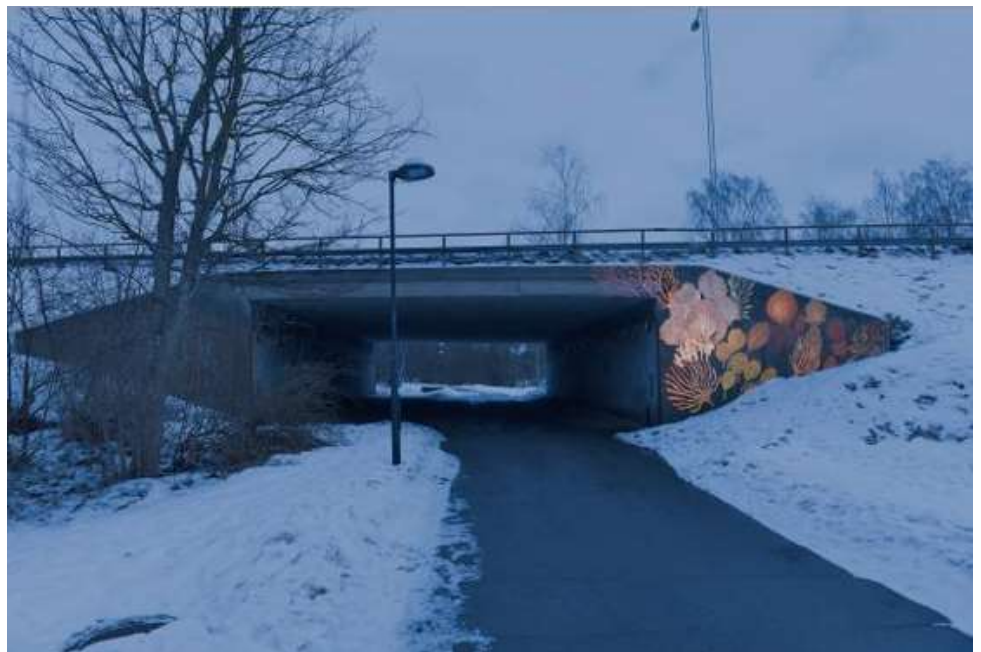
Figur 8, Exempel på hur på effektbelysningen vid tunneln under Magelungsvägen kan komma att se ut. Färg och motiv är ännu inte klart.
