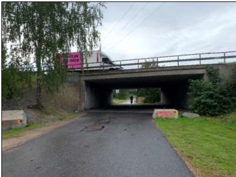
Figur 5, Gång- och cykelvägen i tunnel under Magelungsvägen under dagtid då belysningen i tunneln inte är tänd.
