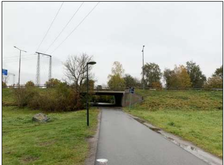
Figur 4, gång- och cykelvägen mellan Magelungsvägen och Nynäsbanan. Tunneln under Magelungsvägen syns i bild.
