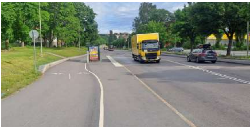
Figur 7. Fotografi som visar Västberga Allé norrut mellan Västberga gårdsväg och Drivhjulsvägen, efter ombyggnad. Kontoret har anlagt en breddad gångbana och dubbelriktad cykelbana på västra sidan. På platsen finns ett nytt hållplatsläge för buss.
