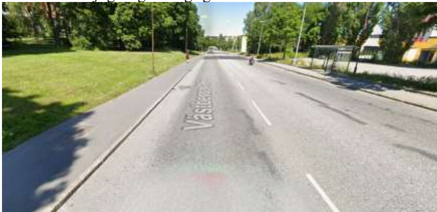
Figur 6. Fotografi som visar Västberga Allé norrut mellan Västberga gårdsväg och Drivhjulsvägen, före ombyggnad. På gatan västra sida syns en smal gångbana och cykelbana saknas.
