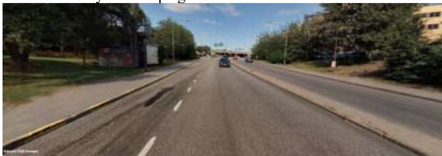
Figur 14. Fotografi som visar Västberga Allé norrut mellan Vretenborgsvägen och Karusellvägen, före ombyggnad. Sträckan hade en smal gångbana och ingen cykelbana.
