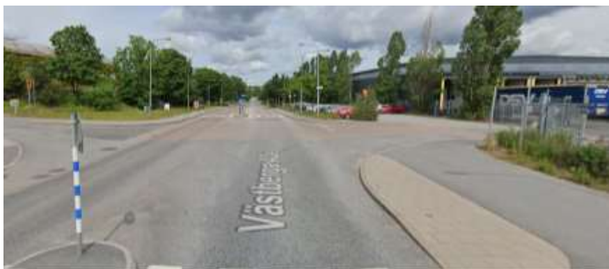
Figur 2. Fotografi som visar Västberga Allé norrut med Västberga Allé bro i ryggen, före ombyggnad. Den gemensam gång- och cykelbana slutar vid infart till fastighet.
