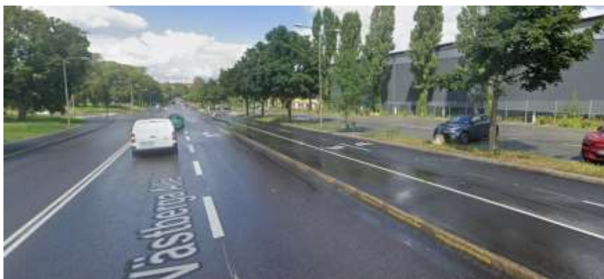
Figur 5. Fotografi som visar Västberga Allé norrut med Västberga Allé bro i ryggen, efter ombyggnad. På gatans östra sida har kontoret anlagt en separerad gång- och cykelbana samt tydliggjort gatans körfält med vägmärkning.
