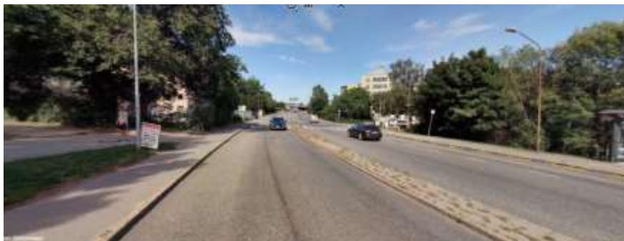
Figur 12. Fotografi som visar Västberga Allé norrut mot Vretenborgsvägen, före ombyggnad. Platsen hade smala gångbanor, ingen cykelbana och en utfart från inre lokalgata med parkering.
