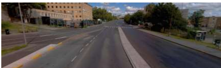
Figur 13. Fotografi som visar Västberga Allé norrut mot Vretenborgsvägen, efter ombyggnad. Kontoret har anlagt en dubbelriktad cykel- och gångväg på den tidigare lokalgatan med parkering som ansluter till cykelbanan norrut.
