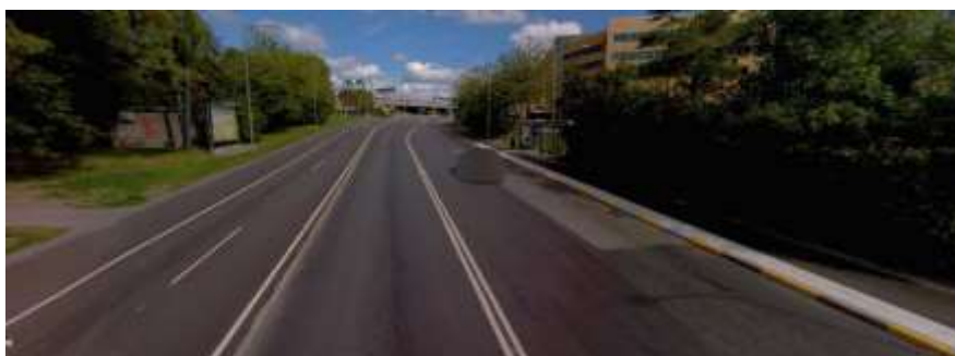
Figur 15. Fotografi som visar Västberga Allé norrut mellan Vretenborgsvägen och Karusellvägen, efter ombyggnad. Sträckan har nu en breddad gångbana och dubbelriktad cykelbana på västra sidan. Busshållplatsen har byggts om och tillgänglighetsanpassats.
