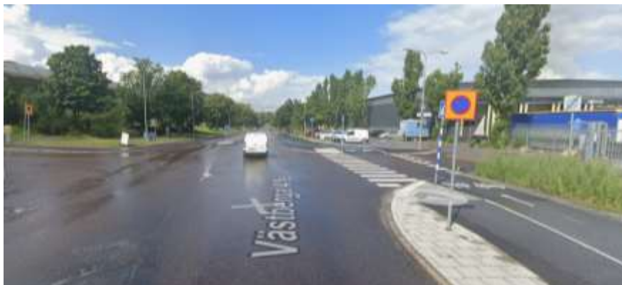
Figur 3. Fotografi som visar Västberga Allé norrut med Västberga Allé bro i ryggen, efter ombyggnad. Kontoret har anlagt separerad gång- och cykelbana med övergångsställe och cykelöverfart över infart till fastighet.
