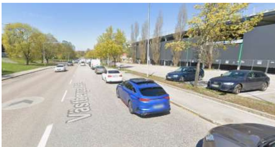
Figur 4. Fotografi som visar Västberga Allé norrut med Västberga Allé bro i ryggen, före ombyggnad. Gångbanan var smal och cykelbana saknades.
