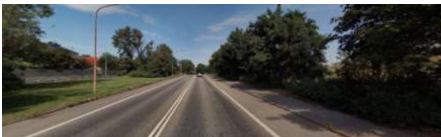
Figur 18. Fotografi som visar Västberga Allé mot Vretenborgsvägen, före ombyggnad. Här var cyklister hänvisade till enkelriktade cykelfält i norrgående riktning och i södergående riktning till cykling i blandtrafik.
