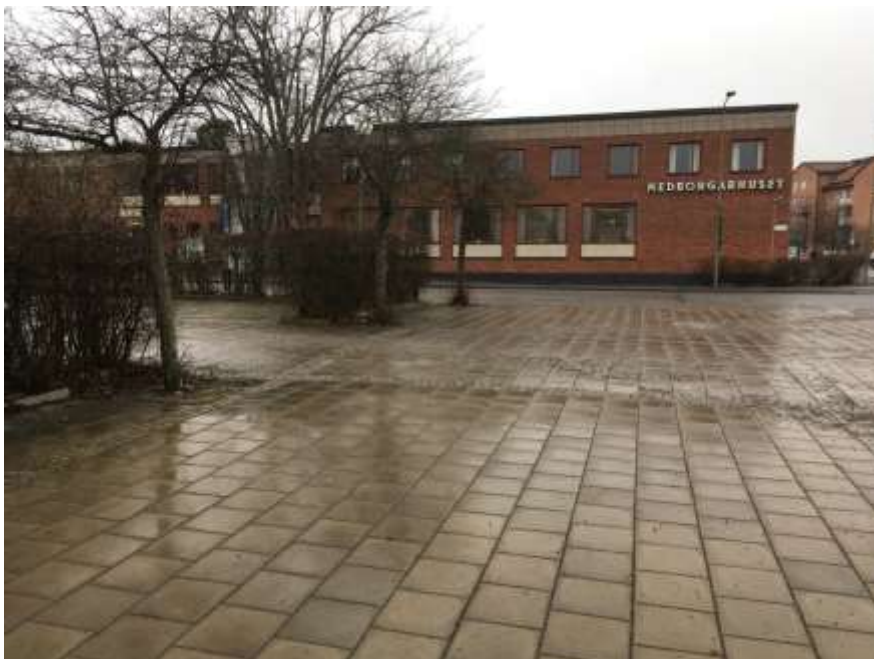
Bild 9. Fotografi som visar torgyta med gamla häckar och träd före ombyggnationen. Denna utformning skapade slutna rum som kunde upplevas som otrygga. Beläggningen på torget hade lågpunkter vilket försämrade avrinningen.
