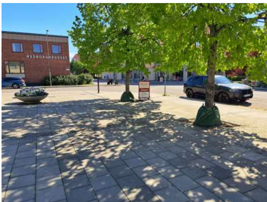
Bild 12. Fotografi efter ombyggnationen där en växtbäddsrenovering utförts, torgytan har lagts om och parkeringsautomaten har tagits bort.
