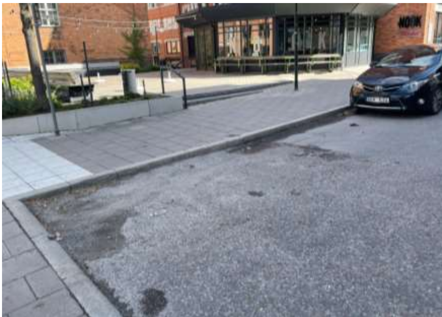
Bild 5. Fotografi som visar gångbana vid Luthens Gränd 1, före ombyggnationen. På platsen saknas möjlighet att låsa fast cyklar.
