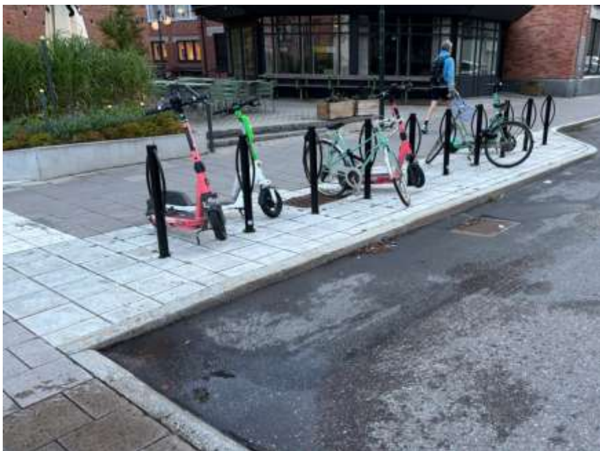
Bild 6. Fotografi som visar utbyggd gångbana med cykelpollare vid Luthens Gränd 1, efter ombyggnationen. Kantstenen har flyttats ut för att kunna behålla gångbanans bredd.
