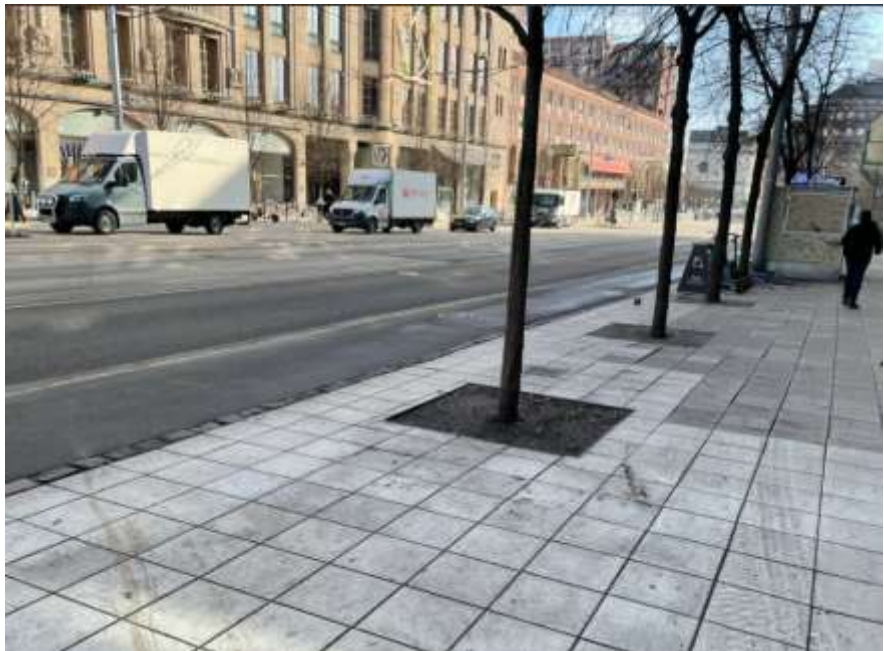
Bild 3. Fotografi som visar gångbana vid Hamngatan 31 i östlig riktning, före ombyggnationen. På platsen saknas möjlighet att låsa fast cyklar.
