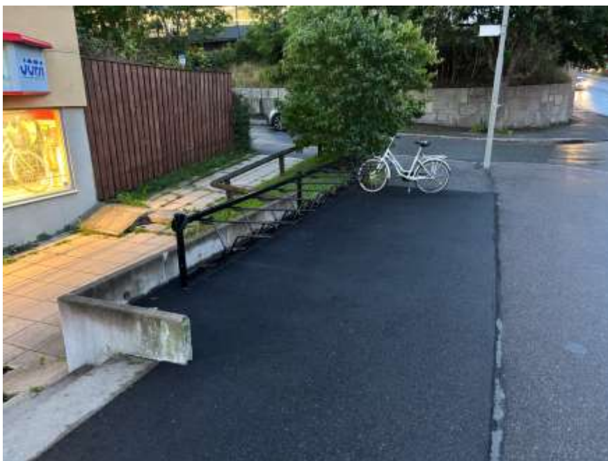
Bild 8. Fotografi som visar gångbana vid Abrahamsbergsvägen 1, efter ombyggnationen. På platsen finns nu möjlighet att låsa fast cyklar i cykelställ med framhjulshållare och ramlås.
