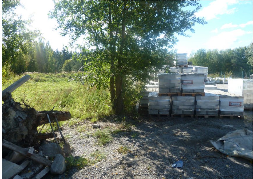
Del av planområdet samt angränsande fastighet sedd från den nordöstra delen av planområdet.
