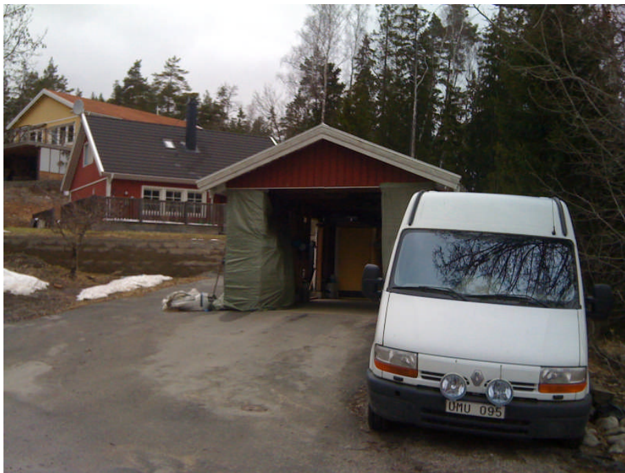
Huvudbyggnad med garage i tomtens södra del
