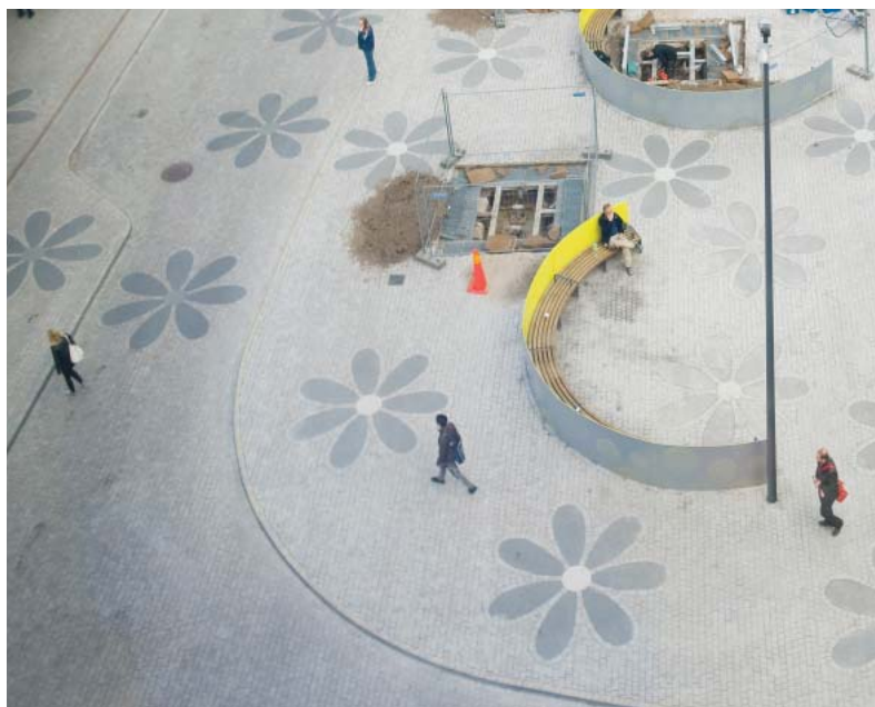
Referens på samma markmaterial i olika nivåer
