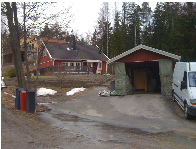
Befintlig huvudbyggnad samt garage på fastigheten Lansjären 1.
