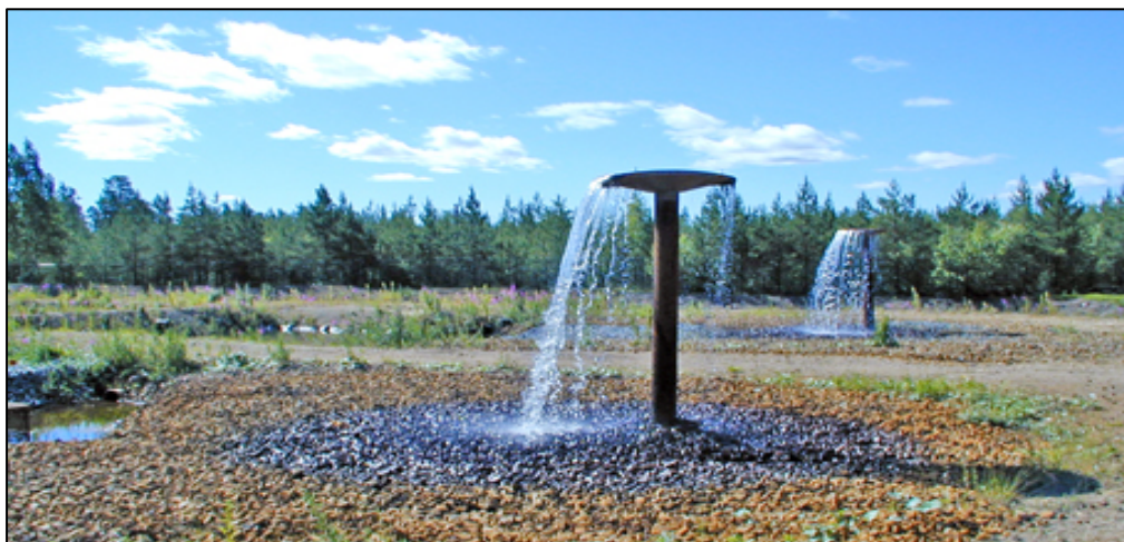
Bild 10: Pålamalms vattenverk i Tungelsta är ett av Haninge kommuns fyra grundvattenverk Foto: Haninge kommuns bildarkiv
