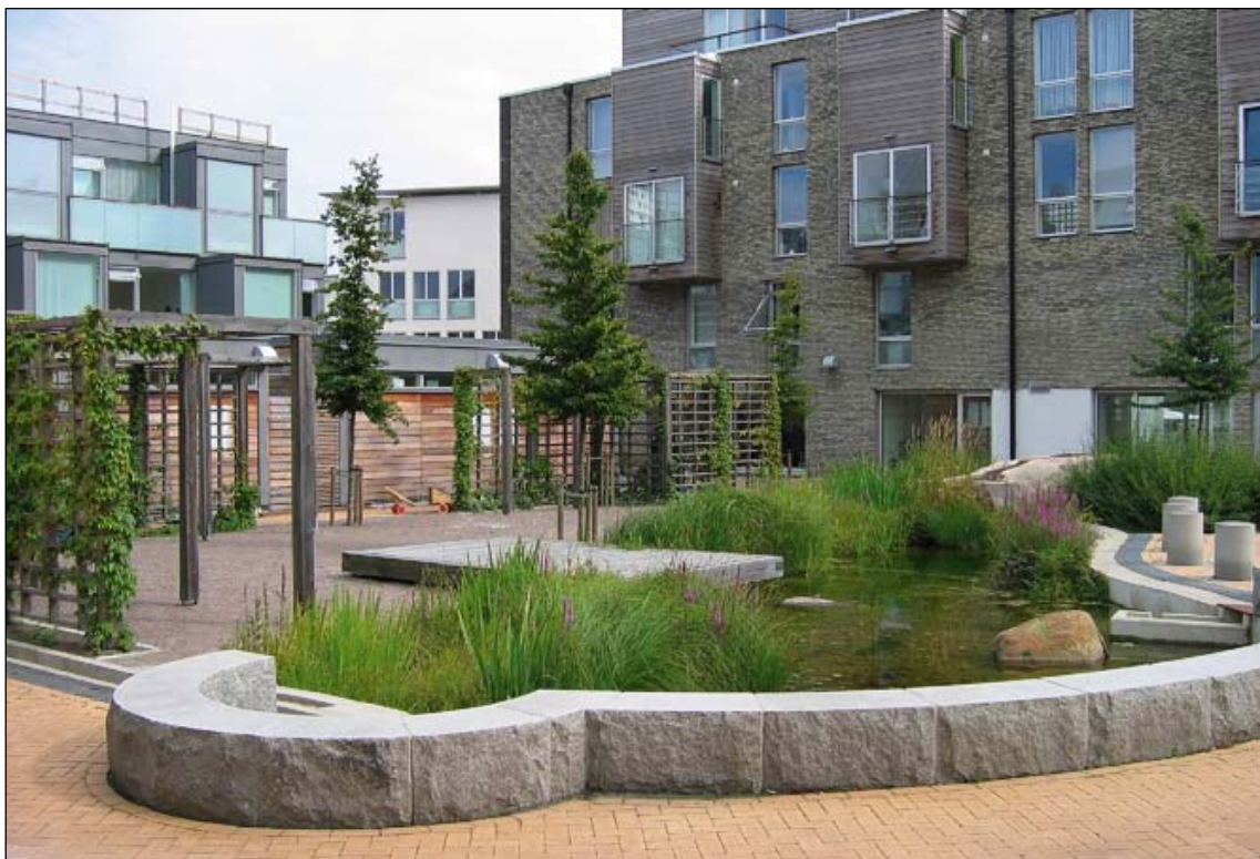
Bild 18: Flödesdämpning och lokalt omhändertagande av dagvatten. Foto: Veg Tech AB
