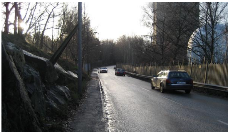
Figur 5.4.3 Befintlig gångbana utmed Gasverksvägen. Foto: Pernilla Westerlund.
