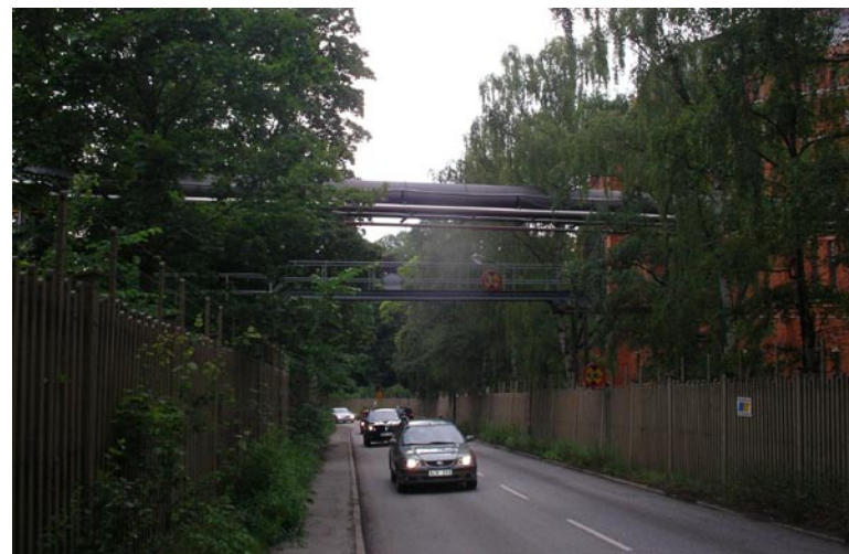
Figur 5.9.1 Gasledning förlagd över Gasverksvägen. Foto: Inger Poveda Björklund.
