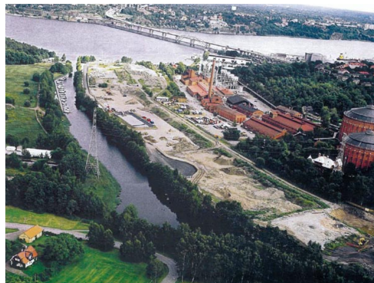
Figur 5.1.5 Flygfoto över Fiskartorpet (nerre till vänster), Husarviken och Gasverksområdet. Boberg's gasklockor ligger i högra kanten av bilden. Ovanför Gasverksområdet ligger Hjorthagsbergets skogklädda sluttning. I bakgrunden ser man Lidingöbron som sammanbinder Ropsten med Lidingö
