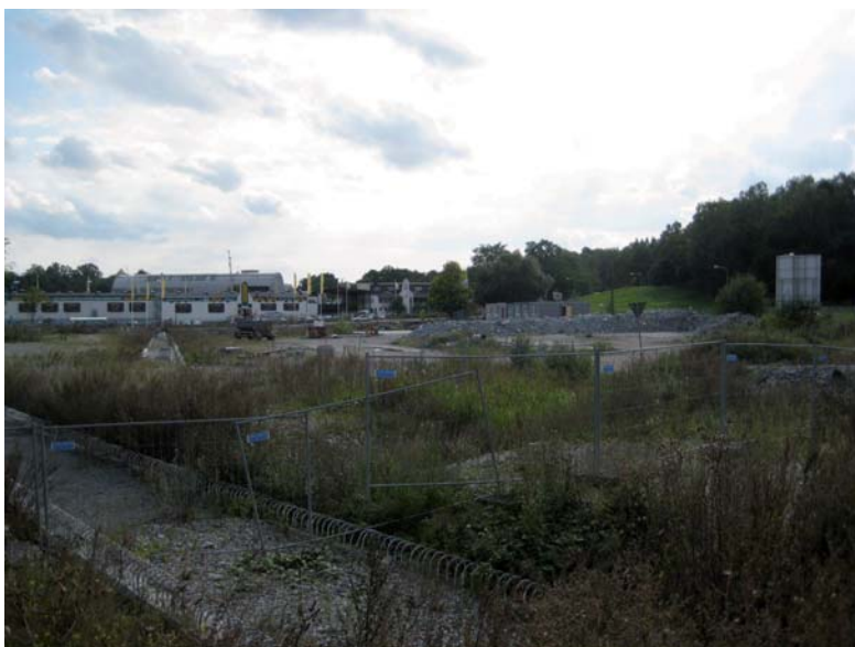
Figur 21. Inom planområdet har vissa saneringsåtgärder vidtagits i samband med anläggning av dagvattenledning.
