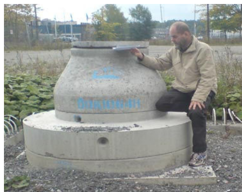
Bild 16. Nyanlagd dagvattenbrunn. Vi föreslår att ett öppet vattenstråk och en mindre damm anläggs i grönkorridoren. Vattnet leds därifrån ned i dagvattenledningen.
