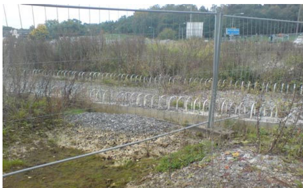
Bild 15. Mark har reserverats för dagvattenledning. Här syns att befintligt dike (bild 14) skärs av.
