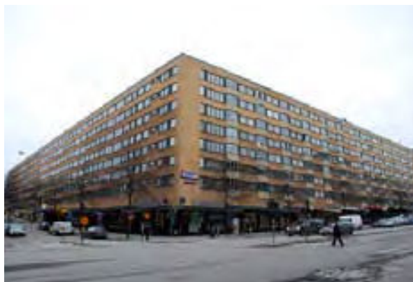
Husets fasader renoveras
