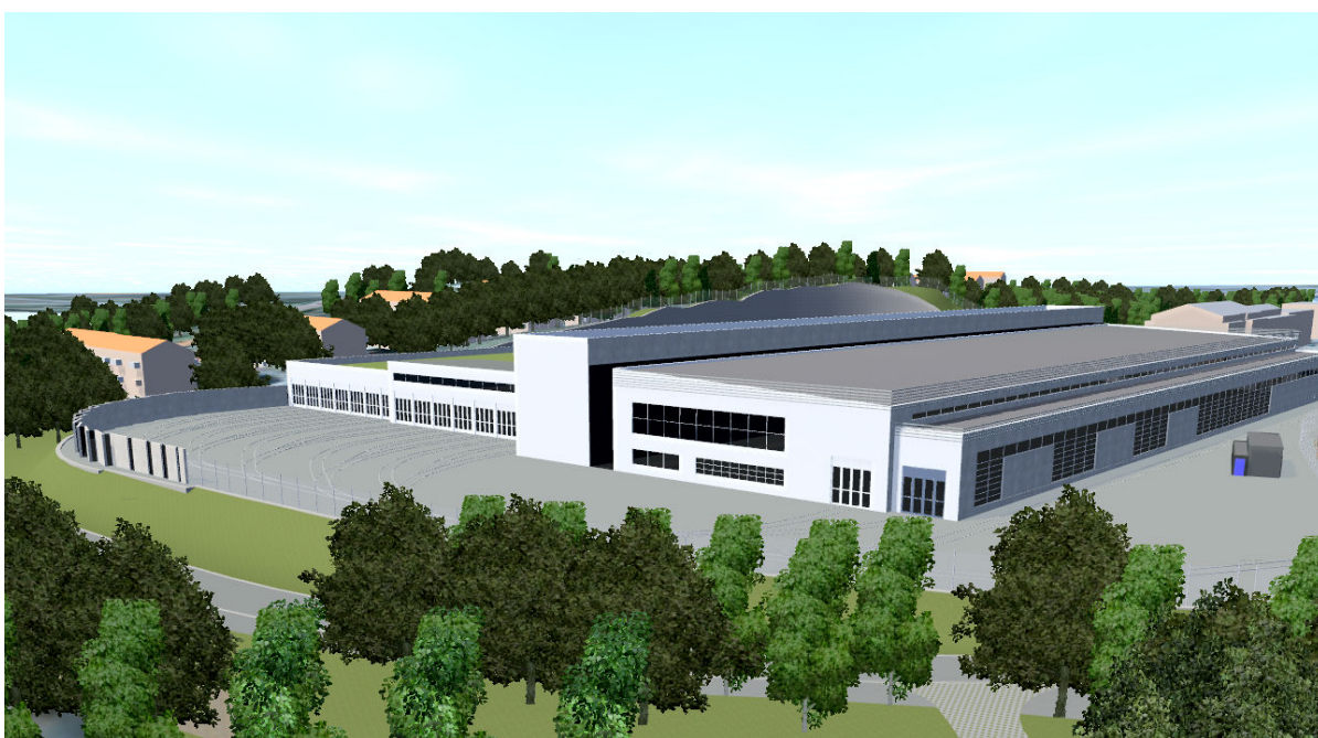
Bild 4 En bild från 3D-modellen som visar depån sett ovanifrån med verkstadshallen närmast och uppställningshallen i en lägre del närmast bostäderna.
