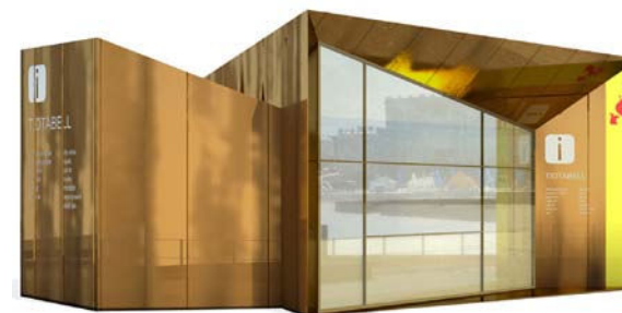
Vy av Strömma Kanalbolagets nya byggnad
