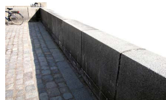
Befintlig mur i kajens södra ände mot Skeppsholmen
