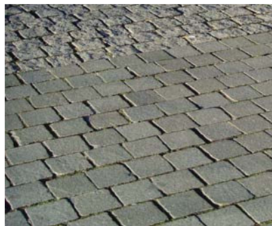
Exempel: Sågad smågatsten (närmast i bild) och vanlig smågatsten
