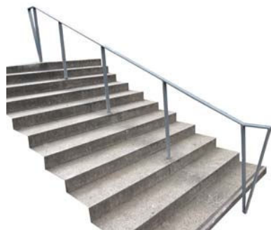
Exempel: Handledare av plattstål
