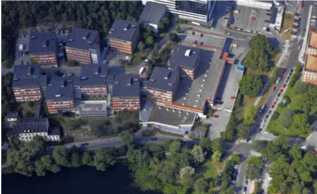
Planområdet sett från öster/vattnet. Från vänster kontorsområdet Racketen 10 med röda kubiska tegelhus och den kulturhistoriskt värdefulla och q-märkta "Vita villan", den låga industridelen, parkeringsdäcken i Racketen 11, den lilla parkytan med tre stora ekar samt längst till höger Gustavslundsvägen.
