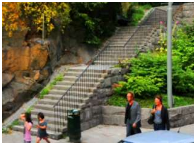
Referensbild som visar stentrappa längs bergsskärning
