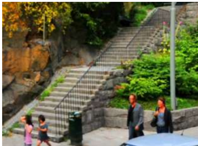
Referensbild som visar stentrappa längs bergsskärning
