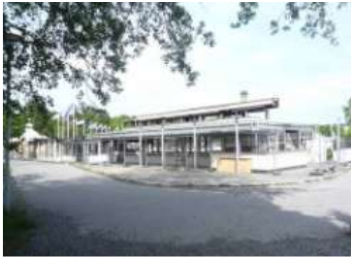
Befintlig byggnad som brunnit
