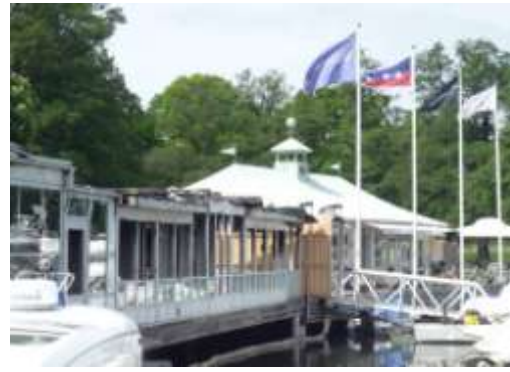
Befintlig byggnad mot småbåtshamnen
