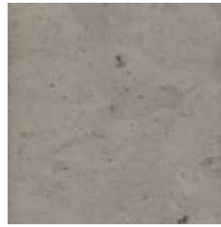
Kalksten i sockel, trappor och ramper
