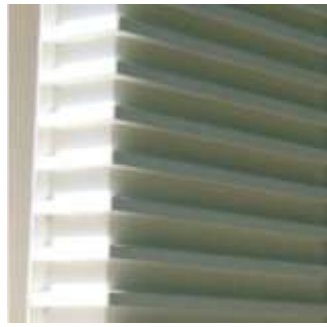
Ribbverk på fasad
