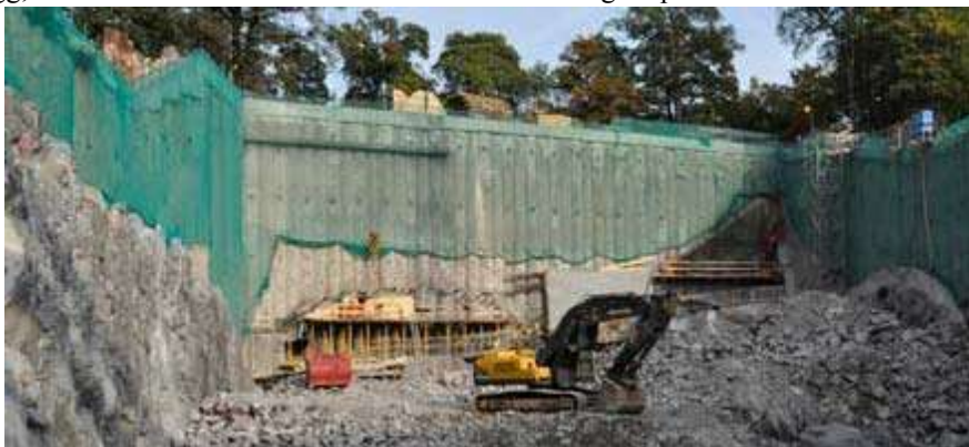
Under Bellevuekullen pågår arbetet med betongtunnelns anslutning till bergtunneln.
