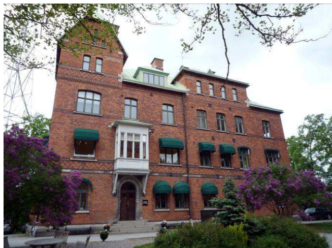
Det befintliga kontorshuset.
