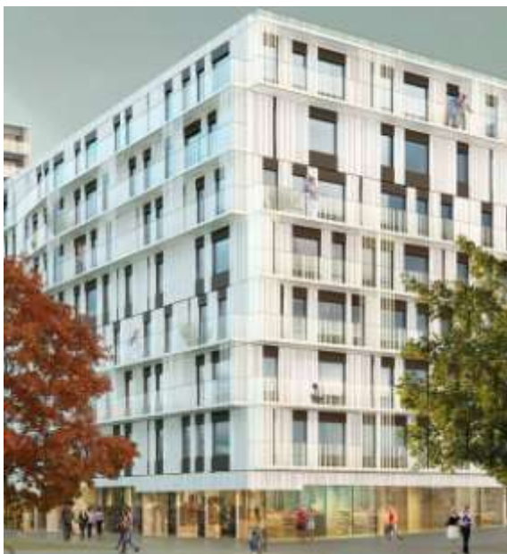
Låghusets hörn mot nordväst, med smala balkonger med glasade räcken
