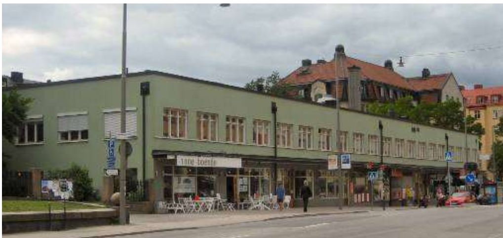
Befintlig byggnad på fastigheten Basaren 1
