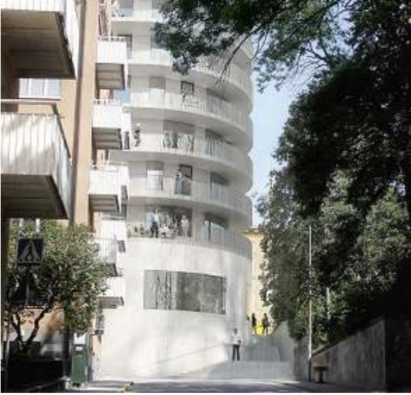
Ny trappförbindelse mellan Hantverkargatan och Baltzar von Platens gata. Wingårdh arkitektkontor
