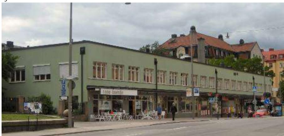
Befintlig byggnad på fastigheten Basaren 1
