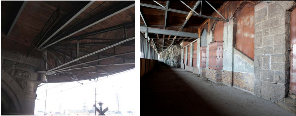
Till vänster en detalj av skärmtakets infästning i stenornamentiken. Till höger ses perrongen med igensatta biljettluckor. Murarna är spritputsade, klädda med hårdbränt fasadtegel eller i natursten. Bild: Stockholms stadsmuseum (båda bilderna).
