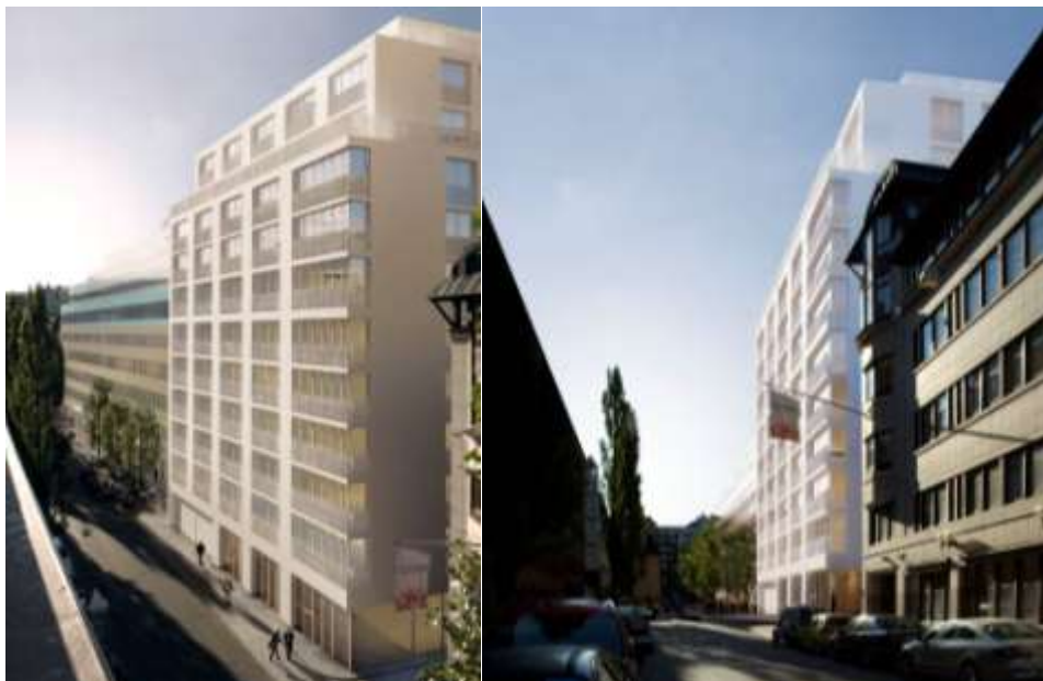
Bostadshuset sett från norr/Luntmakargatan
