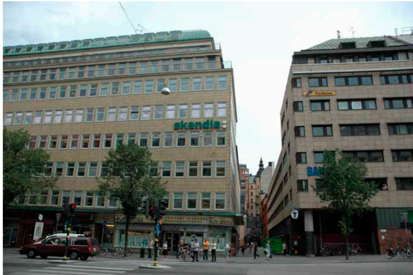
BEFINTLIG VY FRÅN SVEAVÄGEN LÄNGS TUNNELGATAN
